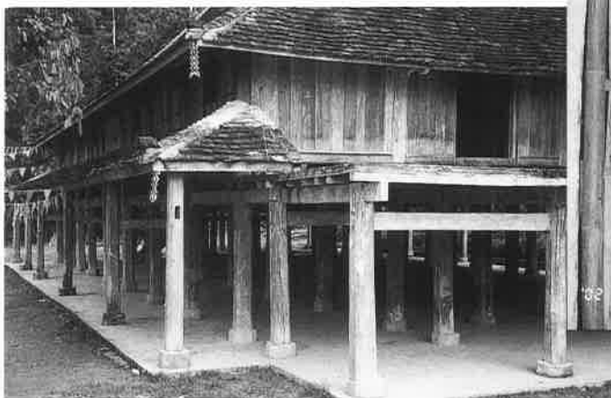
基諾族（ジノー族）博物館外観 基諾族（ジノー族）の伝統的高床式家屋を模した建物
